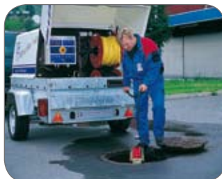
Assainissement des canalisations
