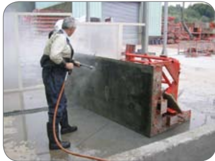
Décapage de banches métalliques
